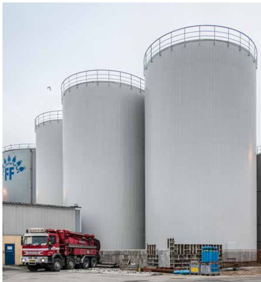
Nye højisolerede olietanke hos FF giver mulighed for opvarmning af olie – både den, der skal renses – og den rensede klar til afskibning.
